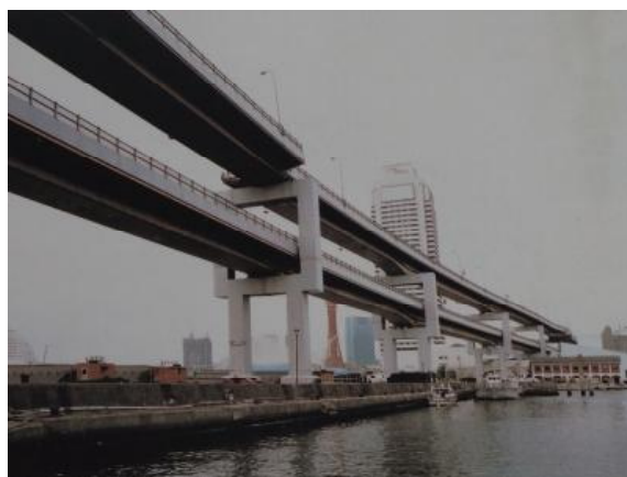
橋桁(はしげた)が横にずれた国道2号浜手バイパス
